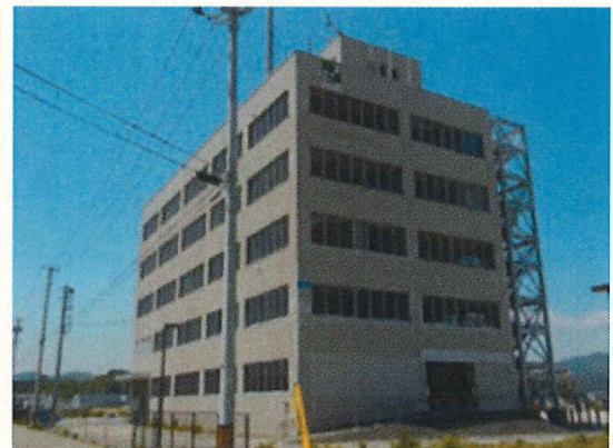
【気仙沼合同庁舎外観】
